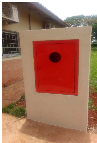
Figura 15: Instalação de hidrantes
