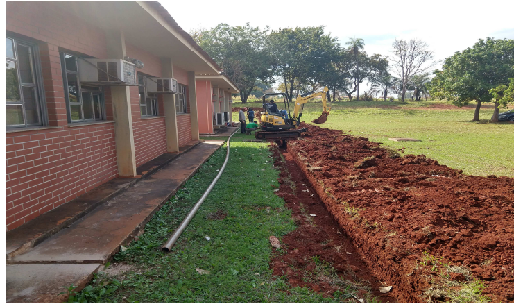
Figura 13: Execução de Rede de água para abastecimento dos hidrantes
