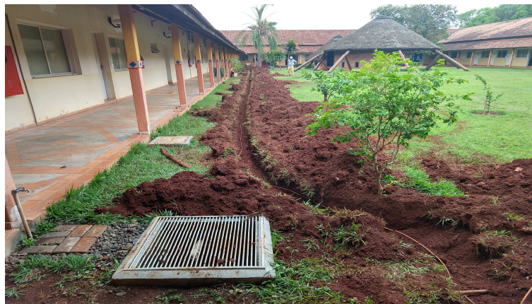
Figura 14: Execução de Sistema de Aterramento
