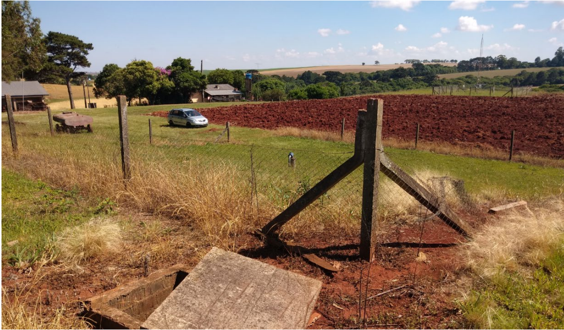
Figura 9. Visão geral do poço tubular 05.
