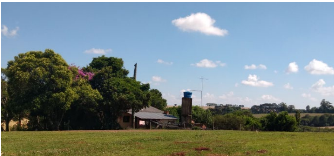
Figura 8. Caixa d'água do poço tubular 04 (consumo humano).
